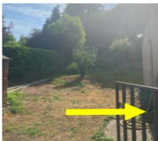
RDC // Future entrée logement 2 (façade gauche du bâti)
