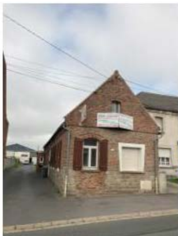
Façade de l'existant sur rue
