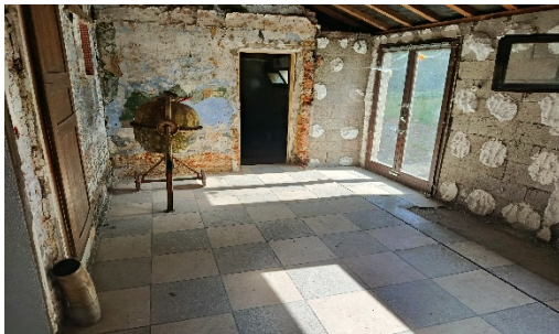
RDC logement 1 future salle de bains et cuisine
