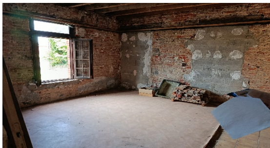
RDC logement 2 Séjour
