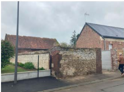
Façade de l'existant côté rue - façade avant
