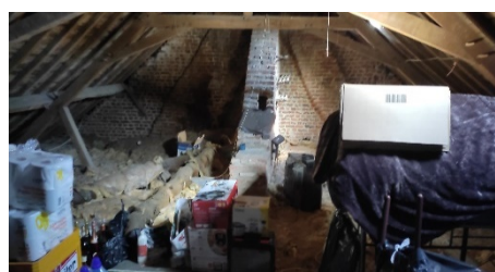
sous les combles
