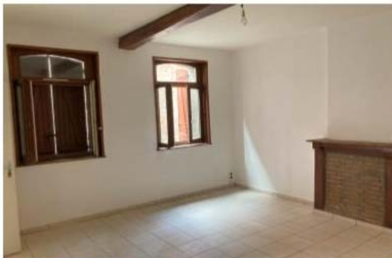
RDC N°25 BIS // Future Chambre 1
