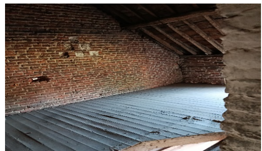
RDC logement 2 Future chambre 2
