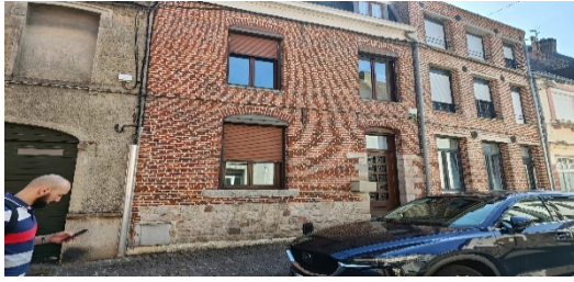
Façade du bâtiment existant
