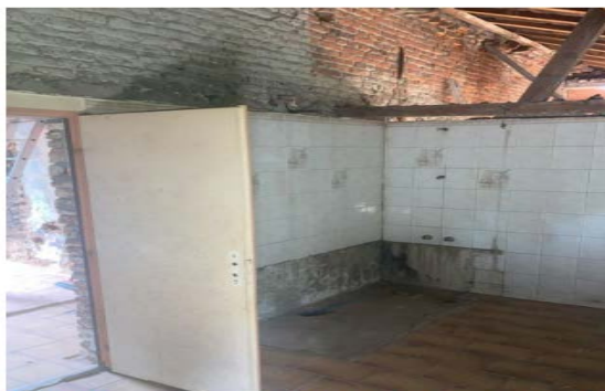
RDC Logement 2 // Future Chambre 1
