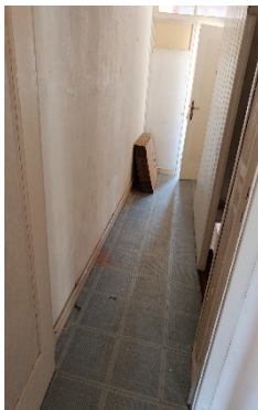
Le couloir R + 1
