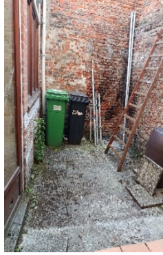
RDC cour (futur SdB et WC)
