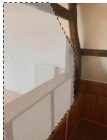
R+1 N°25 // Future séparation des logts
