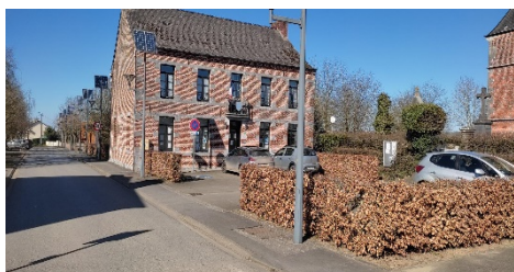
Un projet en centre bourg à l'arrière de la mairie
