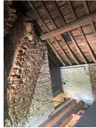
R+1 Logement 2 // Future Chambre 3
