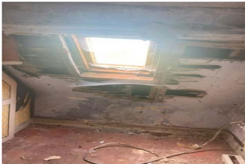
R+1 Logement 1 // Future Chambre 2
