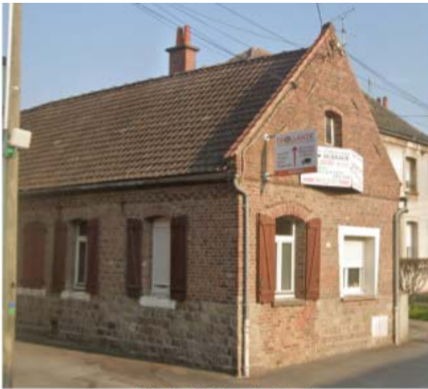
Photo du bâtiment existant
