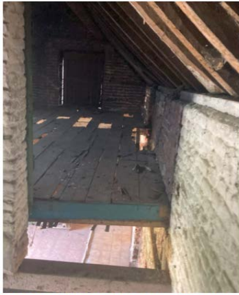
R+1 Logement 2 // Future Chambre 2
