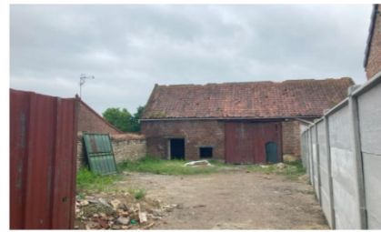
Photo du bâtiment existant
